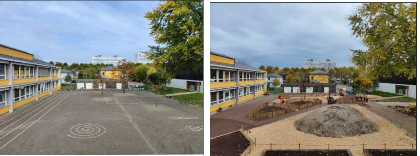
Figure 4 Ecole Canardière avant et pendant les travaux, Strasbourg.eu
