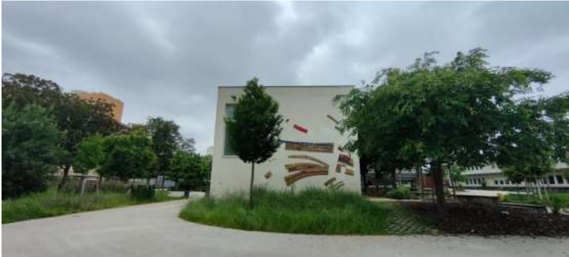
Figure 28 Jonction entre les cours A et B
